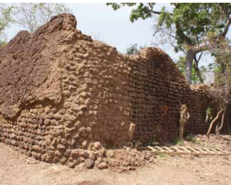
Figure 8 : Angle sud-est après stabilisation. © L. Sîmporé
