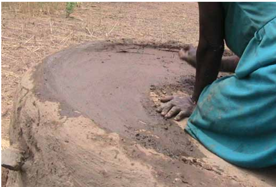
Figure 6 : Crépissage de la tourelle servant de support au grenier. © A. B. Karka/ Site Koutammakou
