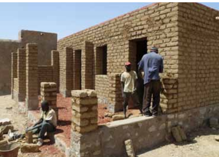
Figure 3 : Logement de base bandiagara MCB. © T. Joffroy
