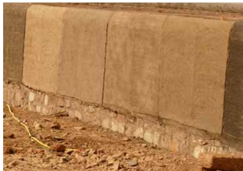
Figure 4 : Recettes d'enduits sur un mur à la Mission culturelle. © L. Cissé
