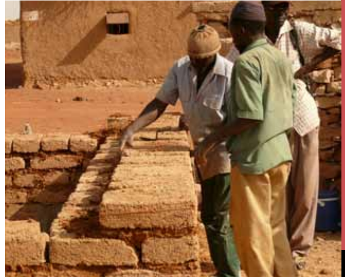
Figure 8 : Chantier-école MCB, 2008. © L. Cissé
