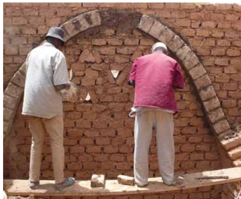
Figure 5 : Construction voûte MCB. © L. Cissé
